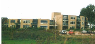
Appartementen aan de Viswei
